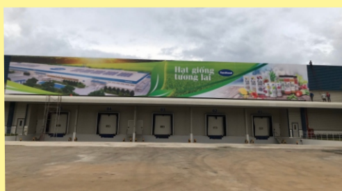
02 cái bảng pano cỡ lớn 7 x 12.5m thi công tại công ty Tanifood
